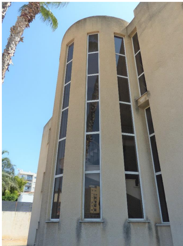
Νέο κτήριο, εξωτερική όψη, βόρεια πλευρά
